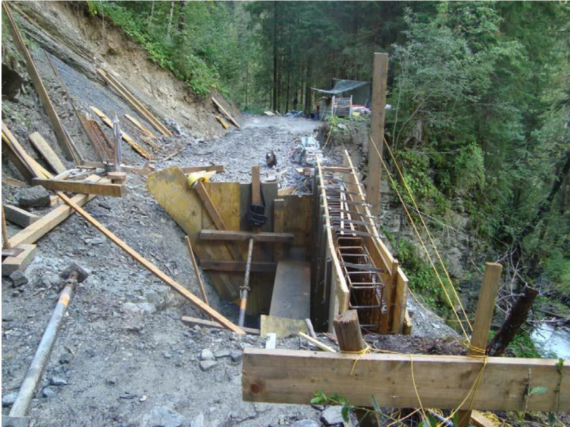
Bild: Sanierung «Sanierung höeji Muur» alte Fermelstrasse
