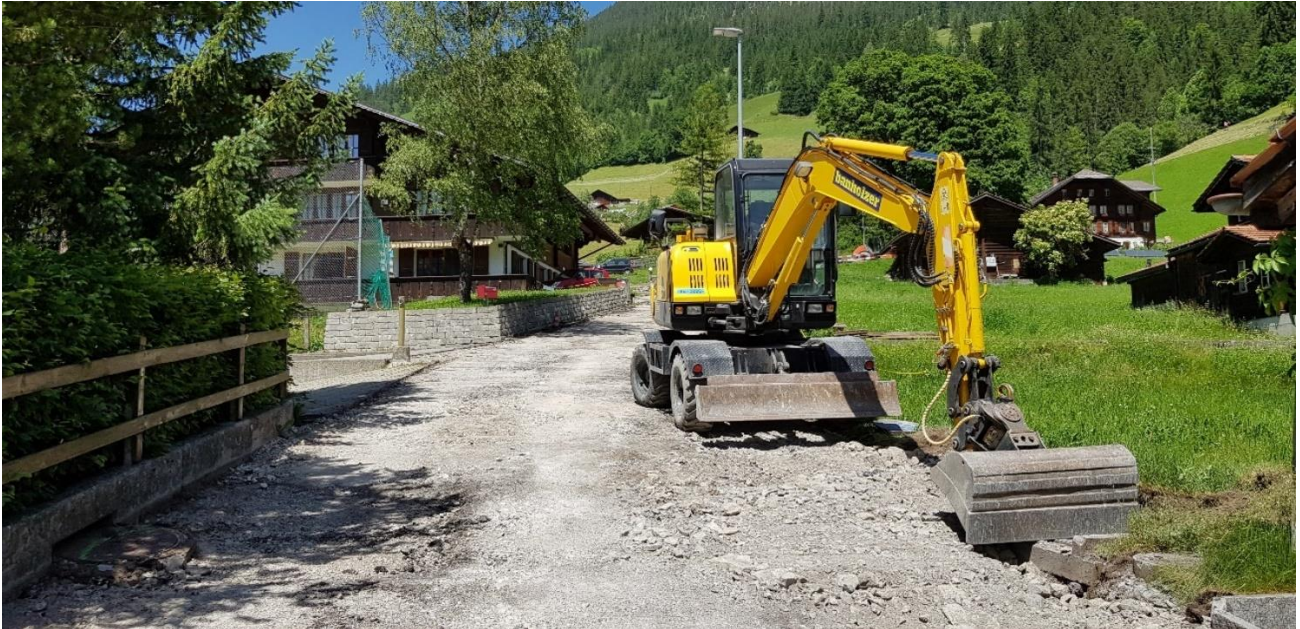
Bild: Sanierung Byfangasse
