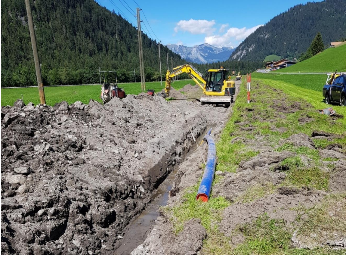
Bild: Leitungsbau in der Wolfey
