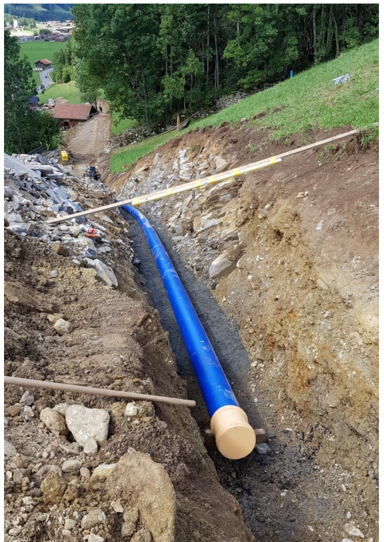
Bilder: Bauleitung Bauarbeiten Mattenhalte-Steinmatte
